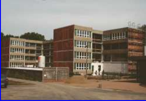
02.08.2007 Abschluss des Fassadenabbruchs
