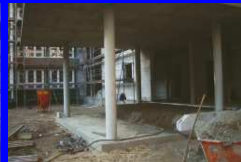
15.10.2007 Das Stahlbetondach des Haupteingangs ist ausgeschalt
