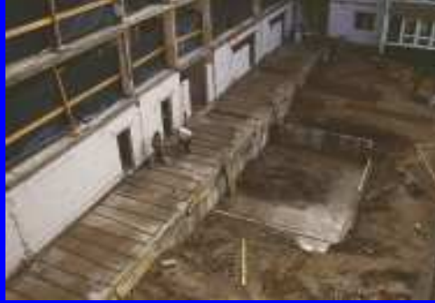
23.08.2007 Bodenplatte des vorgesetzten Flures und Baugrube Haupteingang
