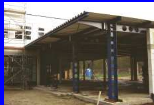
01.12.2006 Montage des Stahltrapez-Profildaches
