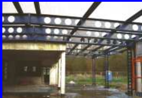
24.11.2006 Die Cellform-Träger des Saales sind montiert
