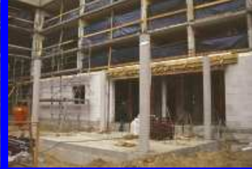
06.09.2007 Stahlbetonstützen des Haupteingangs
