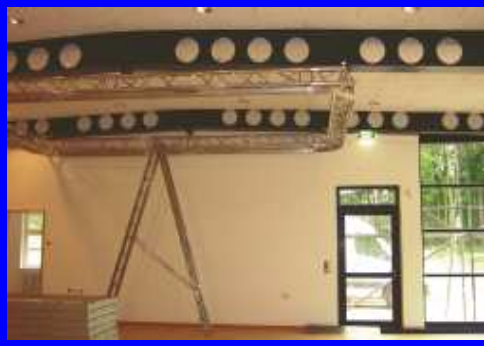
27.06.2007 Einbau der Bühnenvorhangtraverse
